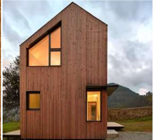
Plotagem sobre placas cimentícias e aplicação de verniz, aplicadas em construção. Imita madeira
