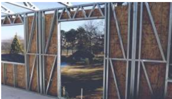
Estrutura de parede em Steel Frame, com placas OSB
