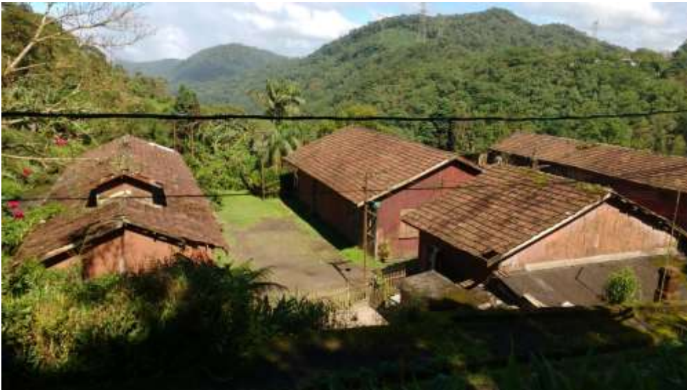
Foto 3 – Vista alta ampliada. Ve-se o 5 prédios
