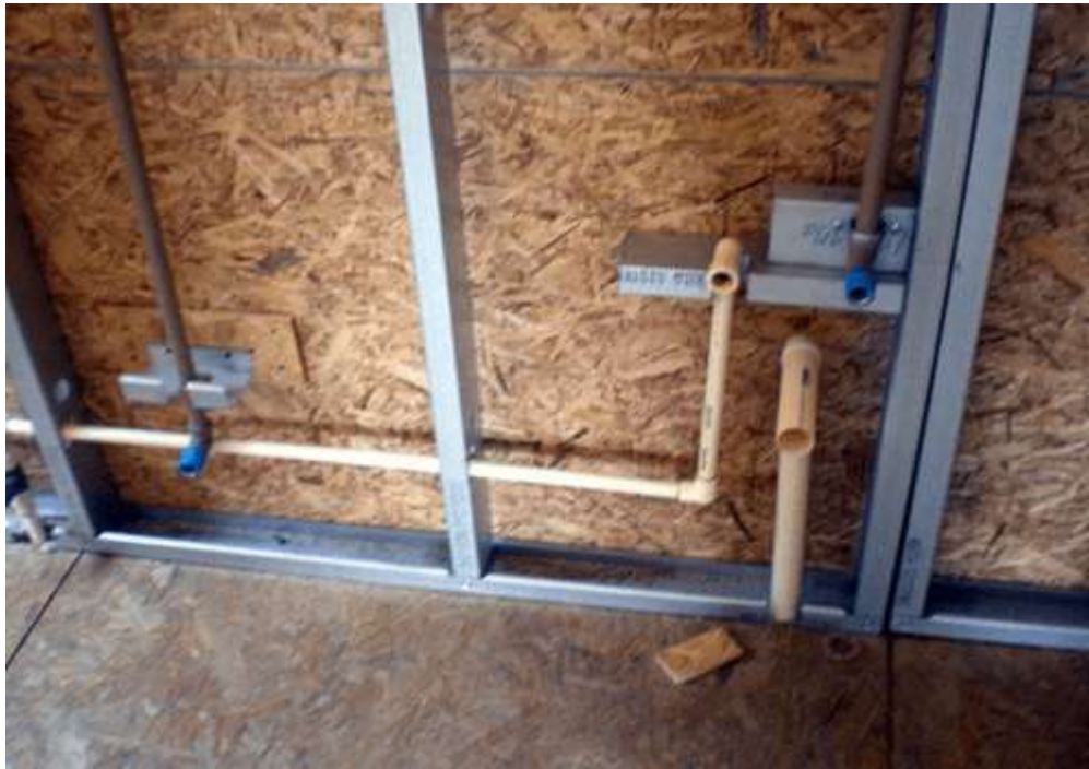
Detalhe da passagem de dutos, antes do fechamento c/ as placas internas Também utilizamos os tubos “pex” e manifold. Todas instalações imbutidas.
