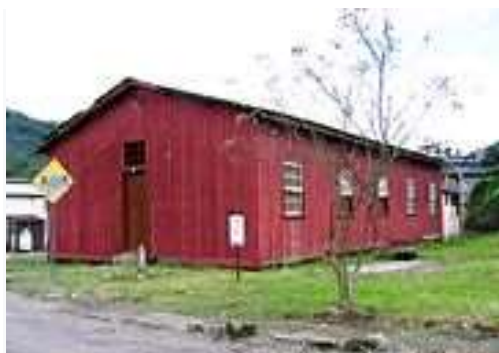
Casa de Solteiro em Madeira
